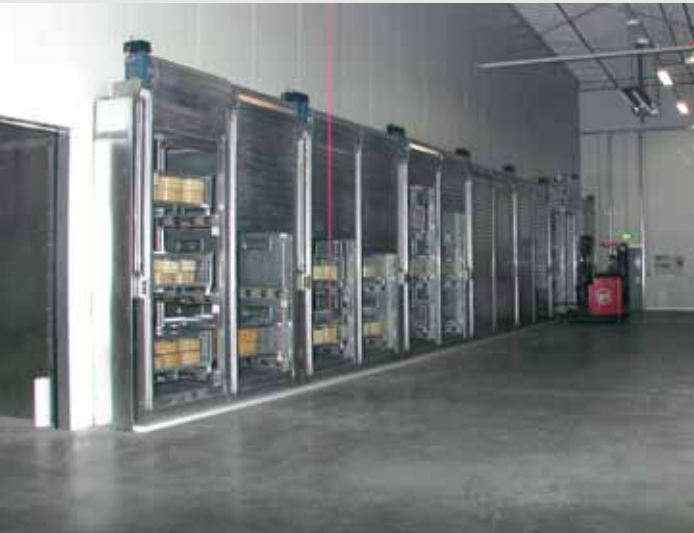
Temperraum · Curing room · Enceinte d'étuvage
