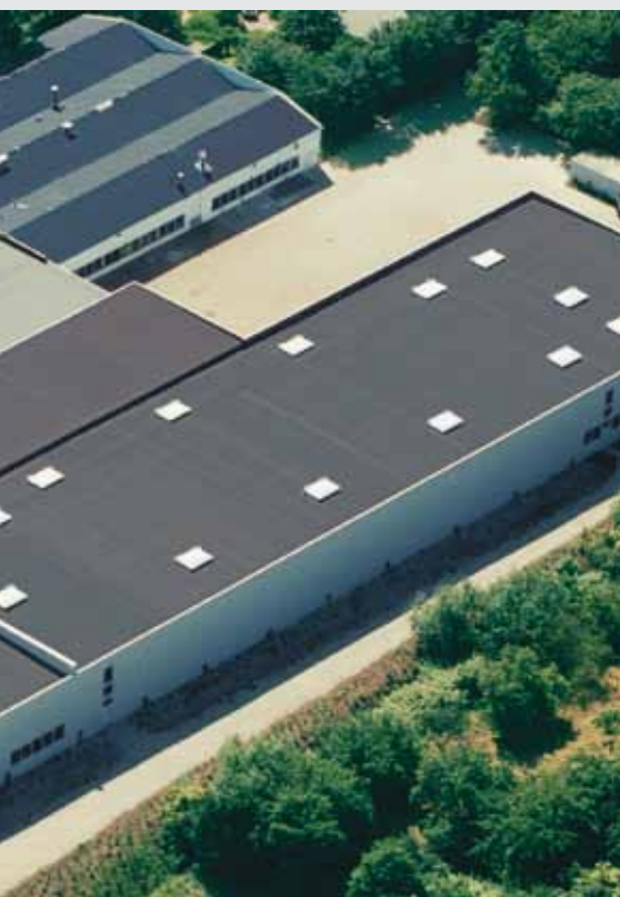
· Versand - Headquarters/Plant I: Mechanical department · PA/TPU nage de métaux · Traitement de PA/TPU · Service d'expédition
